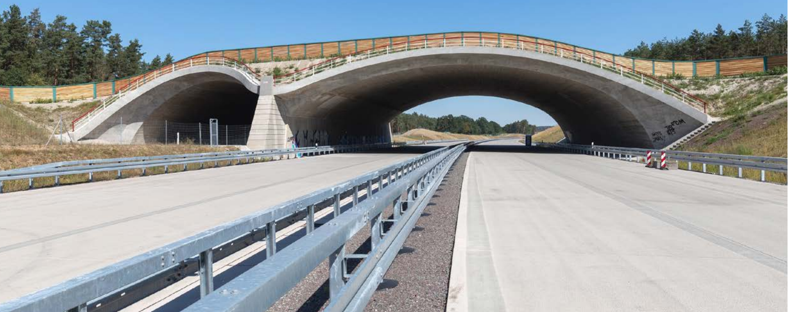
Grün- und Wildbrücke über die A 14 und die Bundesstraße 189 nördlich von Colbitz im Landkreis Börde.
