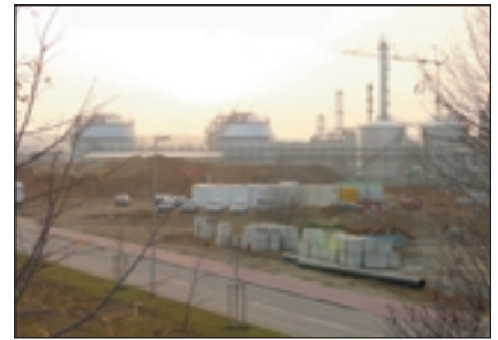
Ansicht des Neuwerkes (Fa. RADICI) Quelle: LAF
