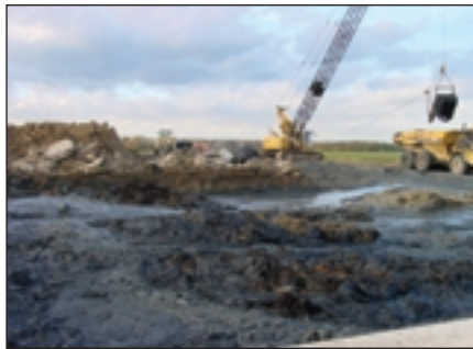
Sanierungsarbeiten auf der Deponie Niephagen Quelle: LAF
