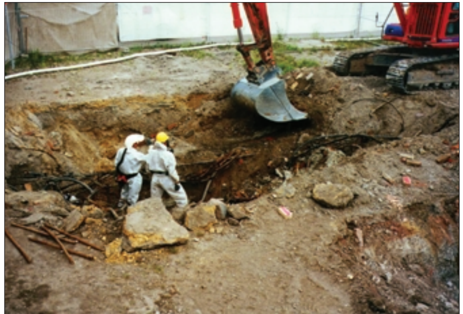
Bodensanierungsarbeiten unter Vollschutz auf dem Werksgelände (Schkopau)
