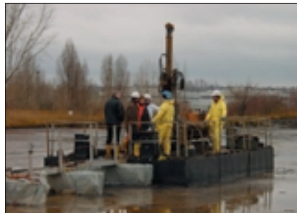
Teerteichsanierung im Addinolprojekt, Erkundungsbohrungen vom Ponton Quelle: LAF
