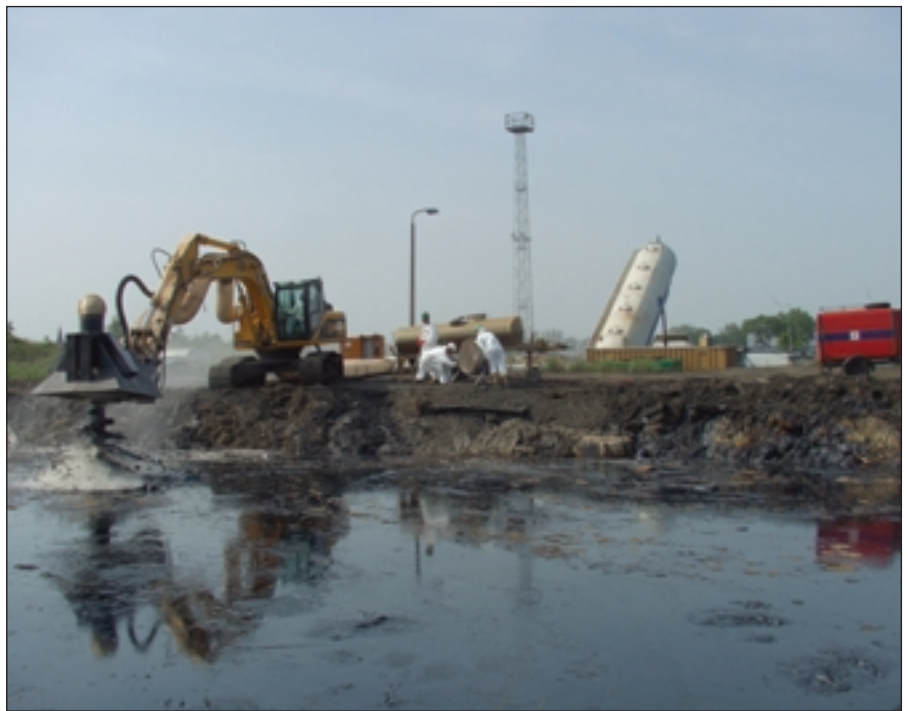
Konditionierungstechnik bei der Teerseesanie rung
