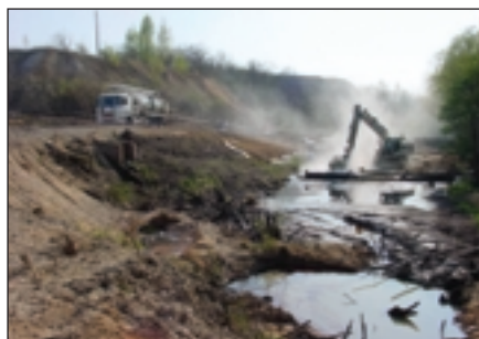
Teerteichsanierung PWW Werk I Quelle: Lobbe
