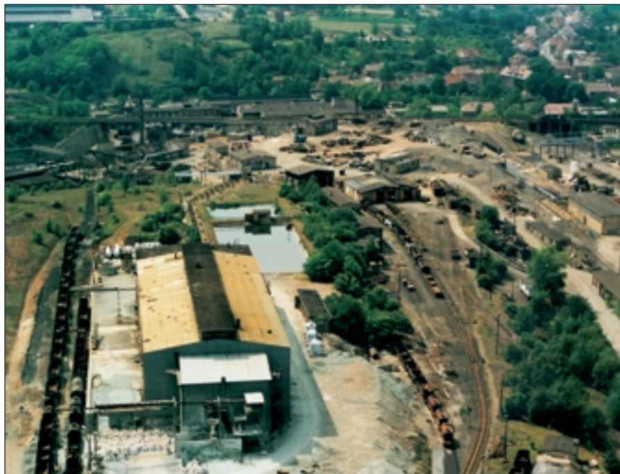
Standort Bleihütte in Hettstedt vor der Sanierung
