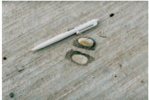
Abb. 1: Zuschlagbedingter Betonschaden im Kappenbereich einer Autobahnbrücke (BAB 14) nördlich Halle. Deutlich zu erkennen ist eine Abplatzung (so genannter „popout“), die durch ein oberflächennahes Kreide-Kieskorn verursacht wurde.
