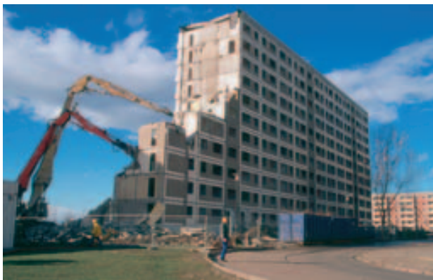
Abb. 9: Abriss eines Plattenbau-Wohnblocks in Halle Silberhöhe im Februar 2002. In diesem Wohngebiet führt der hohe strukturelle Leerstand zum Abbruch großer Komplexe mit einem erheblichen Anfall von rezyklierbarem Betonbruch (Foto: S. MÜLLER, Institut für Geowissenschaften, MLU Halle).
